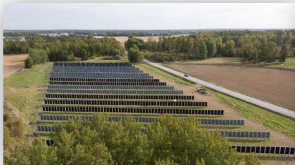
Foto/källa: Ylva Gjeträng – Linde energi
